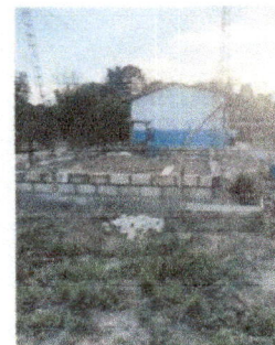
Foto 5: se contempla la adquisicion de pintura para el mantenimiento general del establecimiento y así crear un ambiente confortable a los estudiantes
