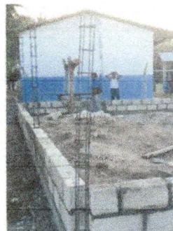
Foto 2: se necesitara de distintos materiales par poder llevar a cabo el proyecto y dar así la ampliación correspondiente al cenro educativo
