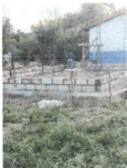
Foto1: se necesitara de instalacion de balcones (ventanas con proteccion que permitan una adecuada ventilacion e iluminacion natural del espacio)
